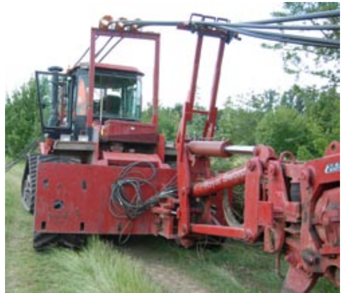
Kabelverlegung Meter für Meter
