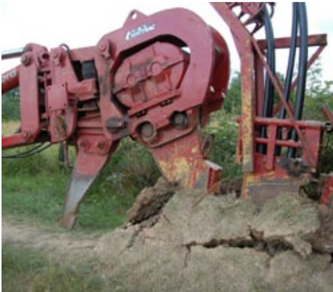
Aufbrechen der Erde
