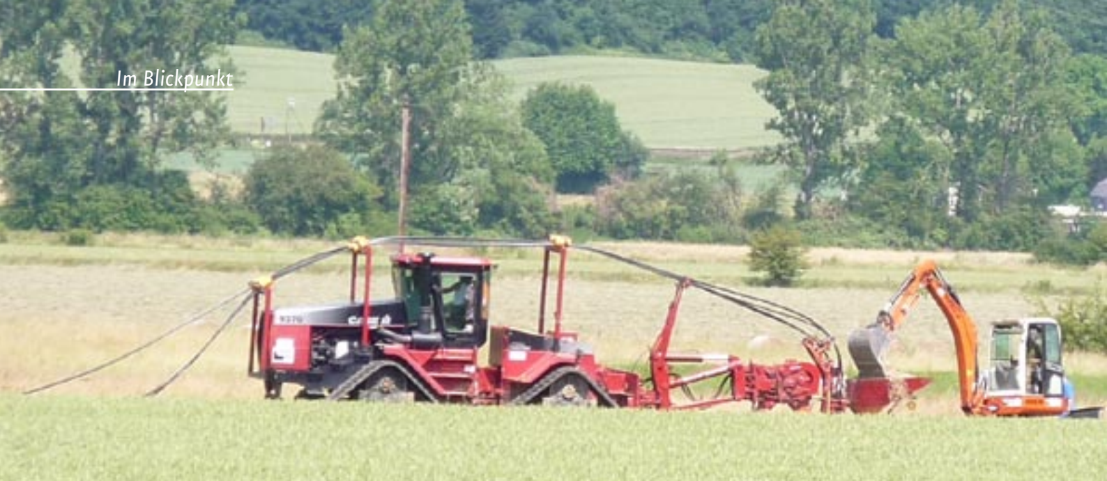
Kabelverlegung zwischen Nidda und Ranstadt
